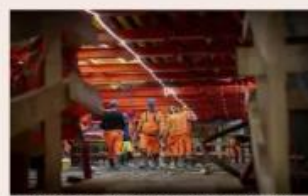
Gjutningen i Fehmarn Bält-tunnels inleds i juli förra året. FOTO: FERNERN A/S
