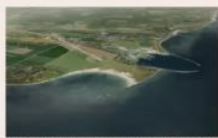
Så här väntas hamnen och tunnelymningen i Puttgarden se ut när projektet är färdigt. ILLUSTRATION: FERNERN A/S
